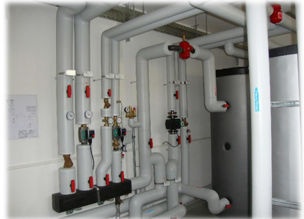
Heizungsverteiler
