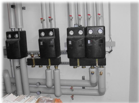
HK-Verteiler FBH Sanitärtrakt
