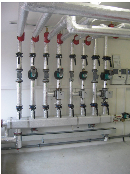
Heizungsverteiler
