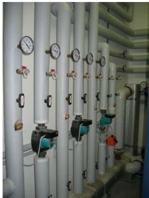
Heizkreisverteiler
